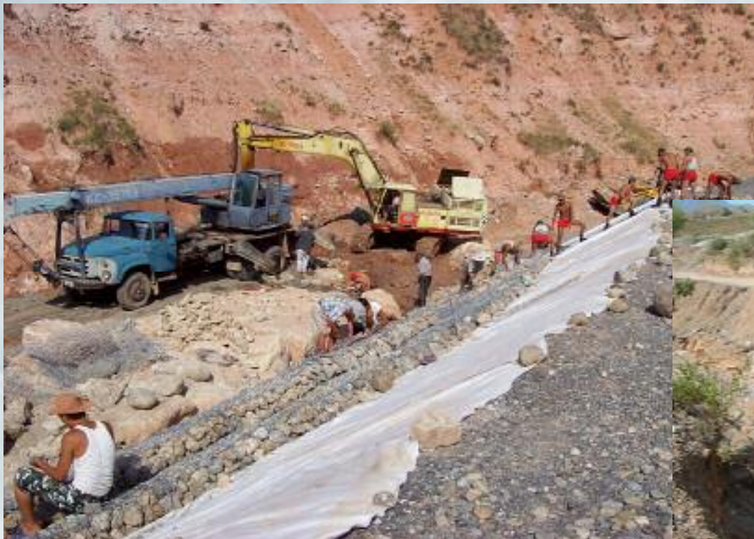
Depósito de Residuos 6
